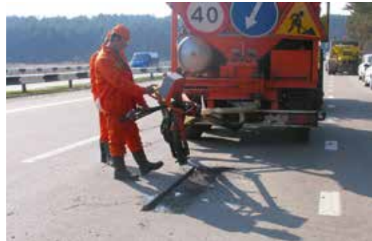
Рисунок 8.18 — Очищення та обробка вибоїни
