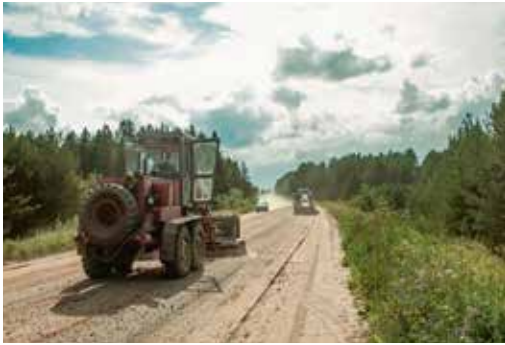
Рисунок 8.16 — Відновлення профілю поверхні покриття
