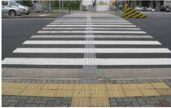
Рисунок 5.16 — Приклад облаштування пішохідного переходу тактильними смугами
