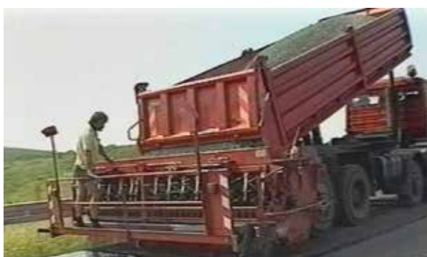
Рисунок 7.11 — Влаштування ЗШЗ за технологією поверхневої обробки
