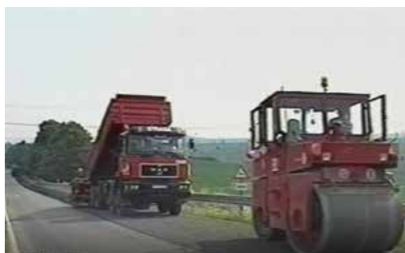
Рисунок 7.11 — Влаштування ЗШЗ за технологією поверхневої обробки
