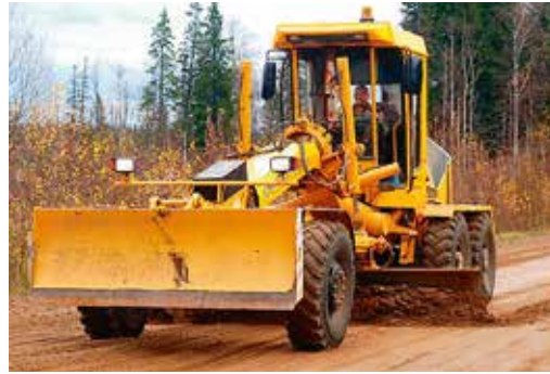
Рисунок 8.16 — Відновлення профілю поверхні покриття
