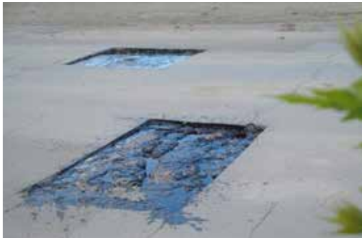
Рисунок 8.18 — Очищення та обробка вибоїни
