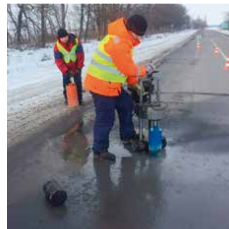
Рисунок 1.15 — Визначення товщин та складу шарів дорожньої конструкції шляхом відбирання зразків-кernів кернавідбірником
