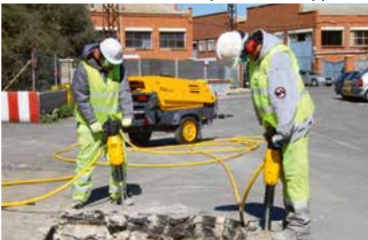
Рисунок 8.17 — Нарізання карт (зліва — за допомогою відбійного молотка; справа — за допомогою ручного бензорізу)
