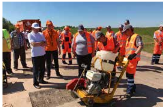
Рисунок 8.17 — Нарізання карт (зліва — за допомогою відбійного молотка; справа — за допомогою ручного бензорізу)
