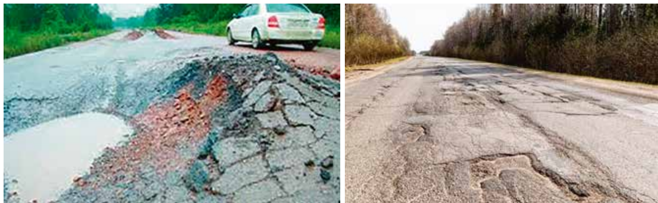
Рисунок 8.15 — Ділянки зі здиманням земляного полотна
